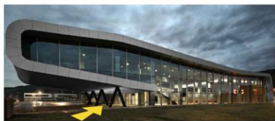
Vista acceso AIC Amorebieta
