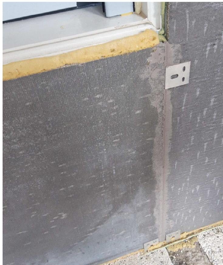
**Figuras 23 y 24:** Detalle fijación Sistema de fachada MULTIZERO a carpintería metálica de ventana y a panel adyacente mediante ménsulas y tornillería de fijación
