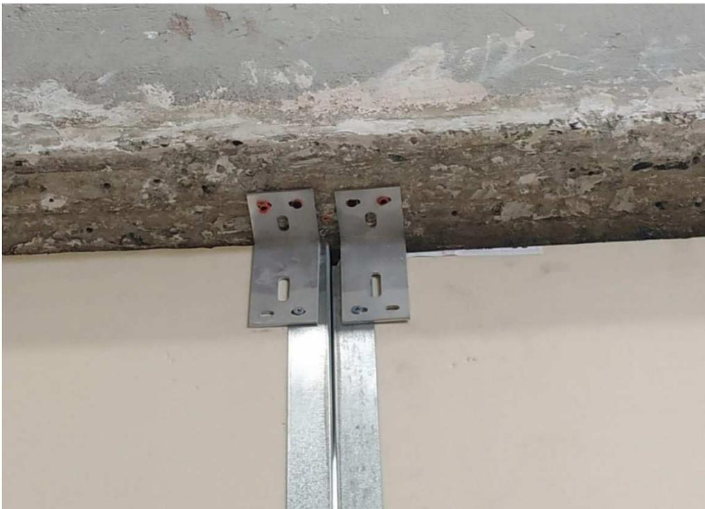
**Figura 25:** Detalle fijación de carpintería metálica de ventana a forjado superior mediante doble ménsula y tornillería de fijación, sobre bloque de EPS
