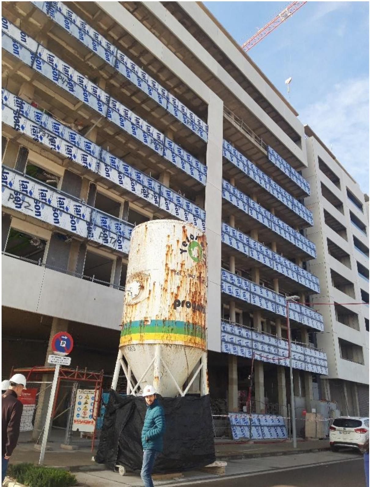
**Figura 20:** Vista general fachada ejecutada con Sistema de fachada MULTIZERO
