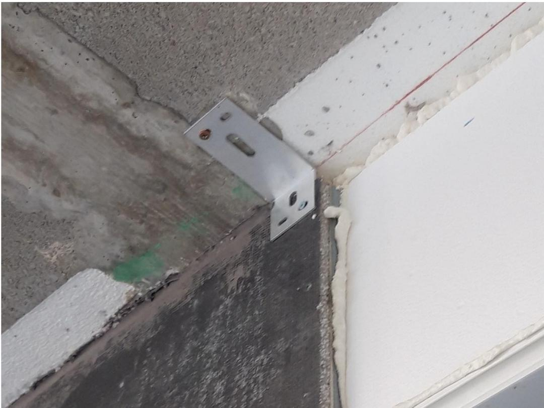
***Figuras 21 y 22: Detalle fijación Sistema de fachada MULTIZERO a forjado superior mediante ménsulas y tornillería de fijación***
