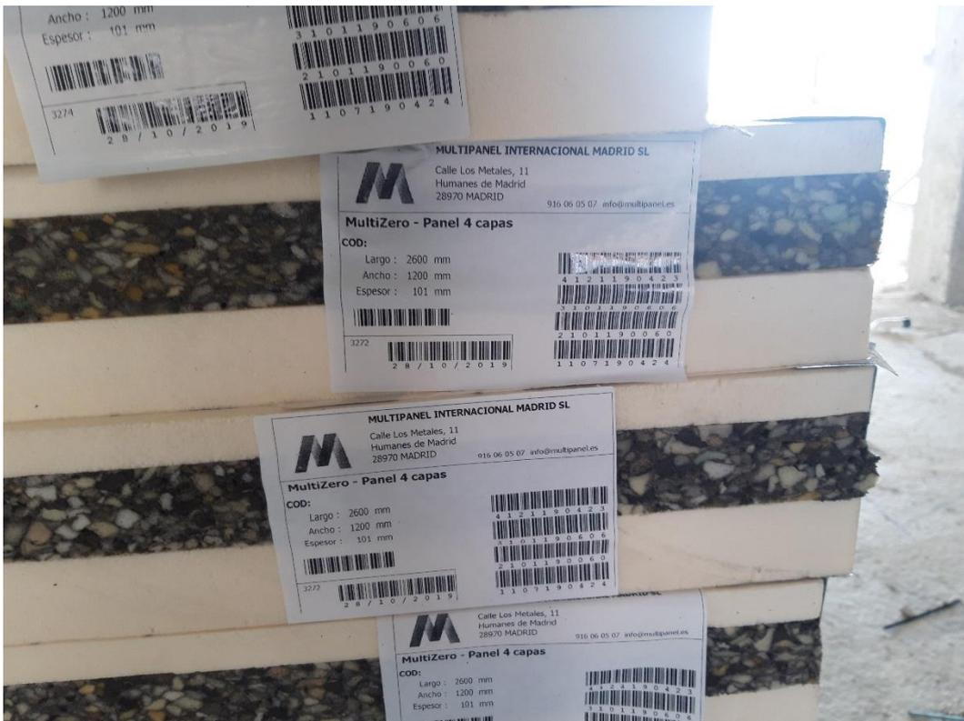
Figuras 27 y 28: Detalle etiquetado paneles MULTIZERO de fachada y de partición interior recibidos en obra
